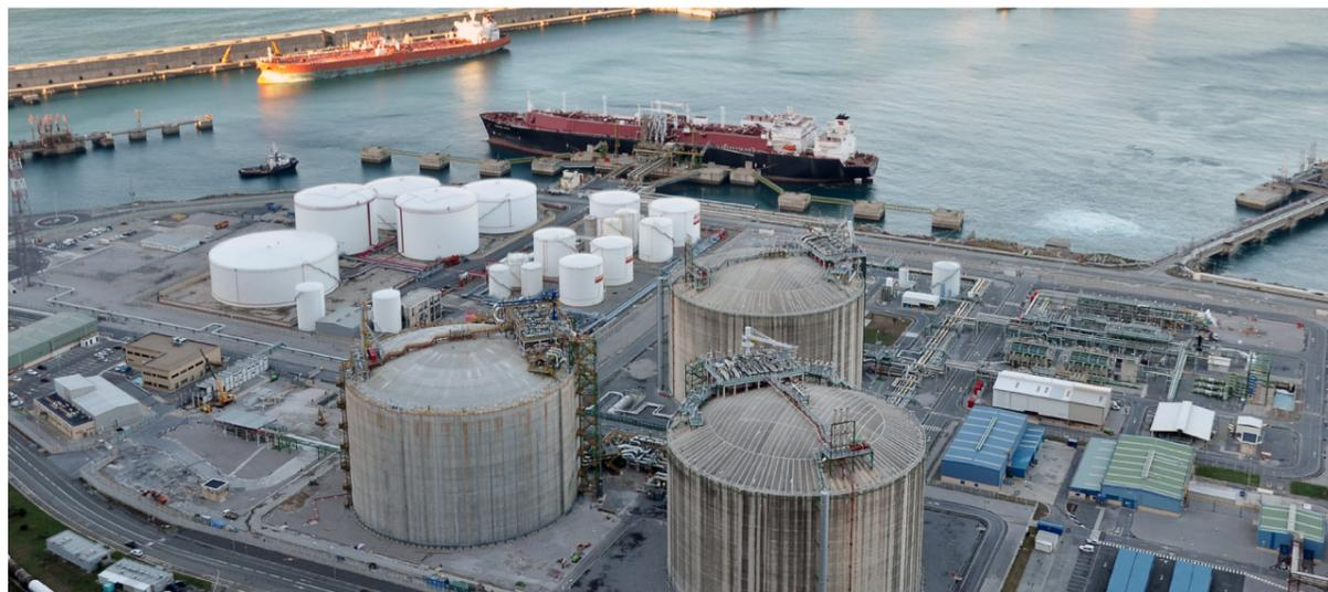
En la actualidad tiene una capacidad de almacenamiento de 450.000 m3 de GNL en tres tanques, de 150.000 m3 cada uno, con una capacidad nominal máxima de emisión de 800.000 Nm3/h y un pantalán para recepción de metaneros de una capacidad máxima de 270.000 m3.
